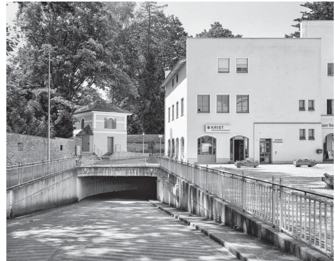
Reparieren statt Umbauen und mit heutigen Materialien einfühlsam ergänzen – die Umnutzung des alten Stadtturms zur Galerie ermöglichte das Nachdenken über Substanzwerte Fotos: Sebastian Schels
