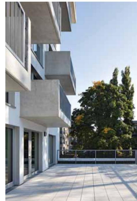
Mit den nach außen verglasten Loggien entsteht eine Pufferzone zur Straße, die den Geräuschpegel im Innenraum senkt
