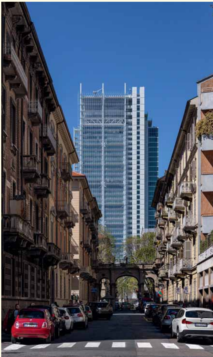
Blick aus der Via S. Quintino auf die Ostfassade des Bankhochhauses Schnitt im Maßstab 1:750
