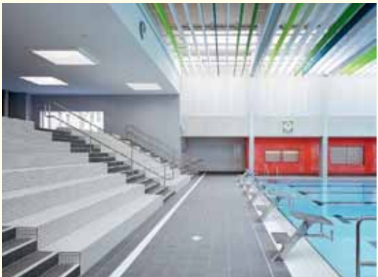
Zwei Kuben ergänzen den Altbau. Tageslicht fällt in die offene, gläserne Schwimmhalle. Eine Treppe über die gesamte Raumbreite verbindet Alt- und Neubau. Fotos: Klemens Ortmeyer; Grundriss und Schnitt im Maßstab 1:500
