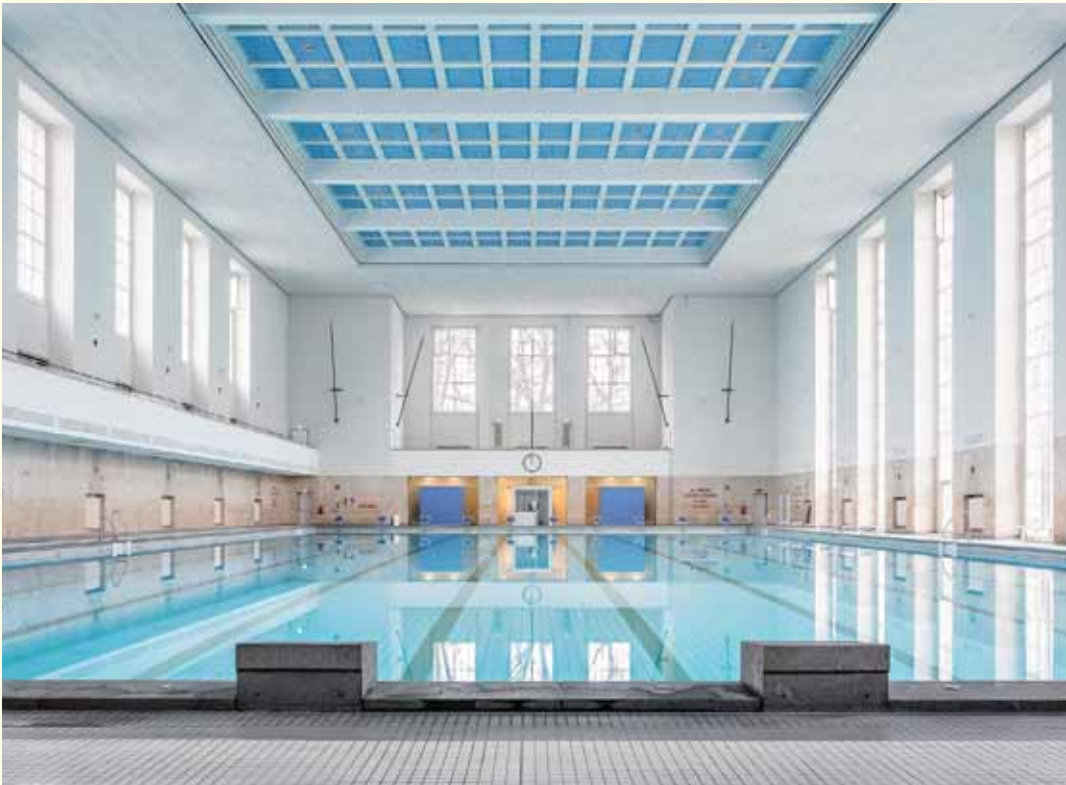
Die einstige Tageslichtdecke musste ersetzt werden, die Raumwirkung sollte aber erhalten bleiben: blaue Deckenfelder gliedern sie nun Schnitt im Maßstab 1:500
