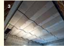
An der Unterkonstruktion 1 hängen die gefalteten Schallschutzplatten 3 . Die Unterkonstruktion der Wände wird mit schallabsorbierenden Elementen ausgefacht 2
