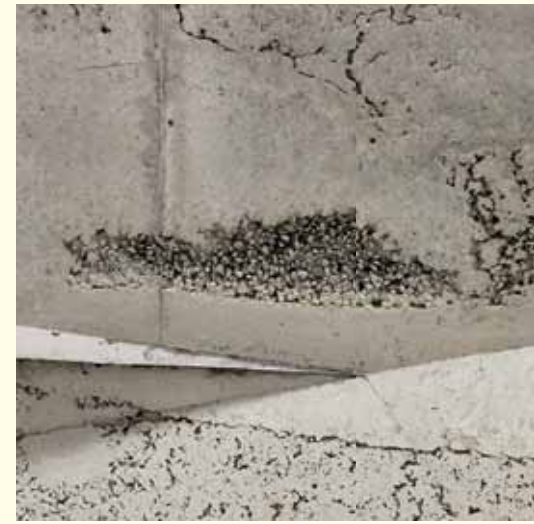
Geplante Fehler: Die beim Betonieren in der Wand entstandenen Hohlräume absorbieren die mittleren Töne
