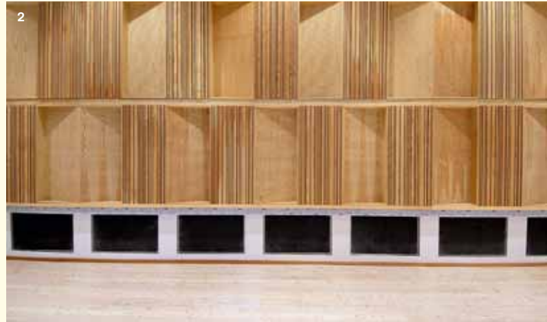
An der Unterkonstruktion 1 hängen die gefalteten Schallschutzplatten 3 . Die Unterkonstruktion der Wände wird mit schallabsorbierenden Elementen ausgefacht 2
