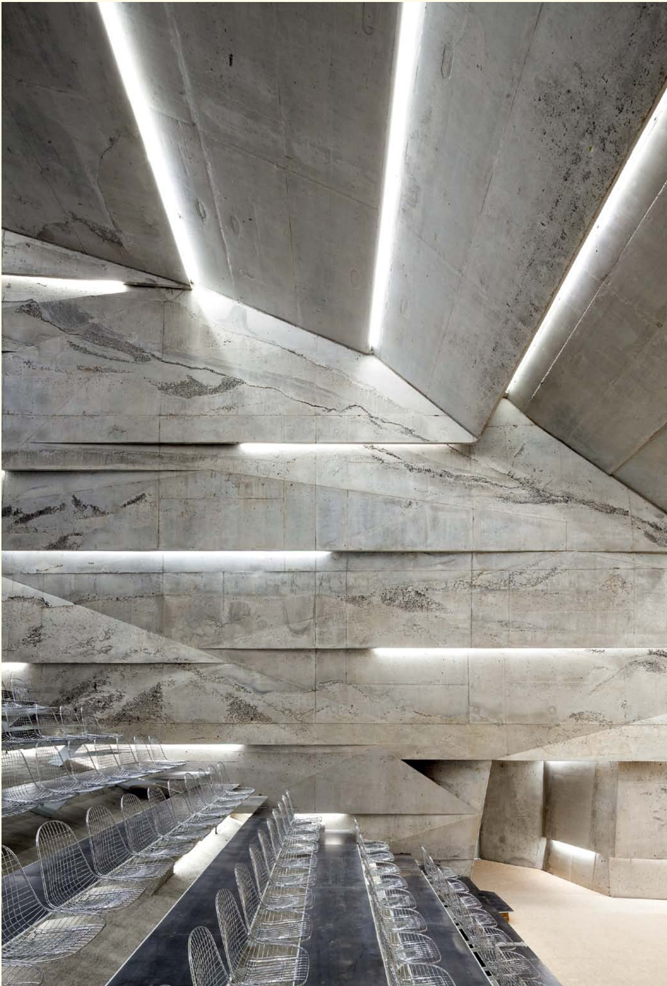
Geplante Fehler: Die beim Betonieren in der Wand entstandenen Hohlräume absorbieren die mittleren Töne
