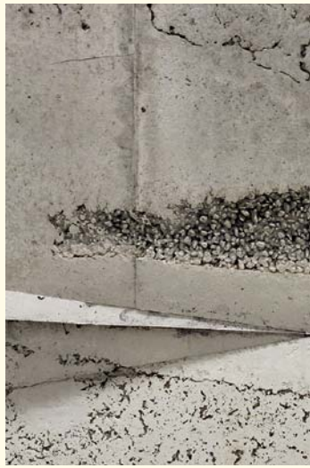
Geplante Fehler: Die beim Betonieren in der Wand entstandenen Hohlräume absorbieren die mittleren Töne
