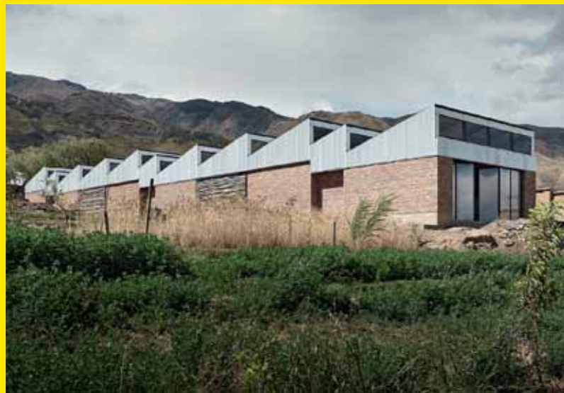
Die Landwirtschaftsschule ist ein Projekt der TU Berlin, gebaut in Kooperation mit bolivianischen Berufsschülern Fotos: Andreas Rost
