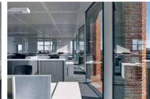
Die Fenster – eine Closed Cavity Fassade von Gartner – spannen rahmenlos von Pfeiler zu Pfeiler, selbst die geknickten Scheiben in den obersten Geschossen sind rahmenlos gestoßen. Das bedeutet aber auch, dass es nirgendwo in den Büros öffentbare Fenster gibt
