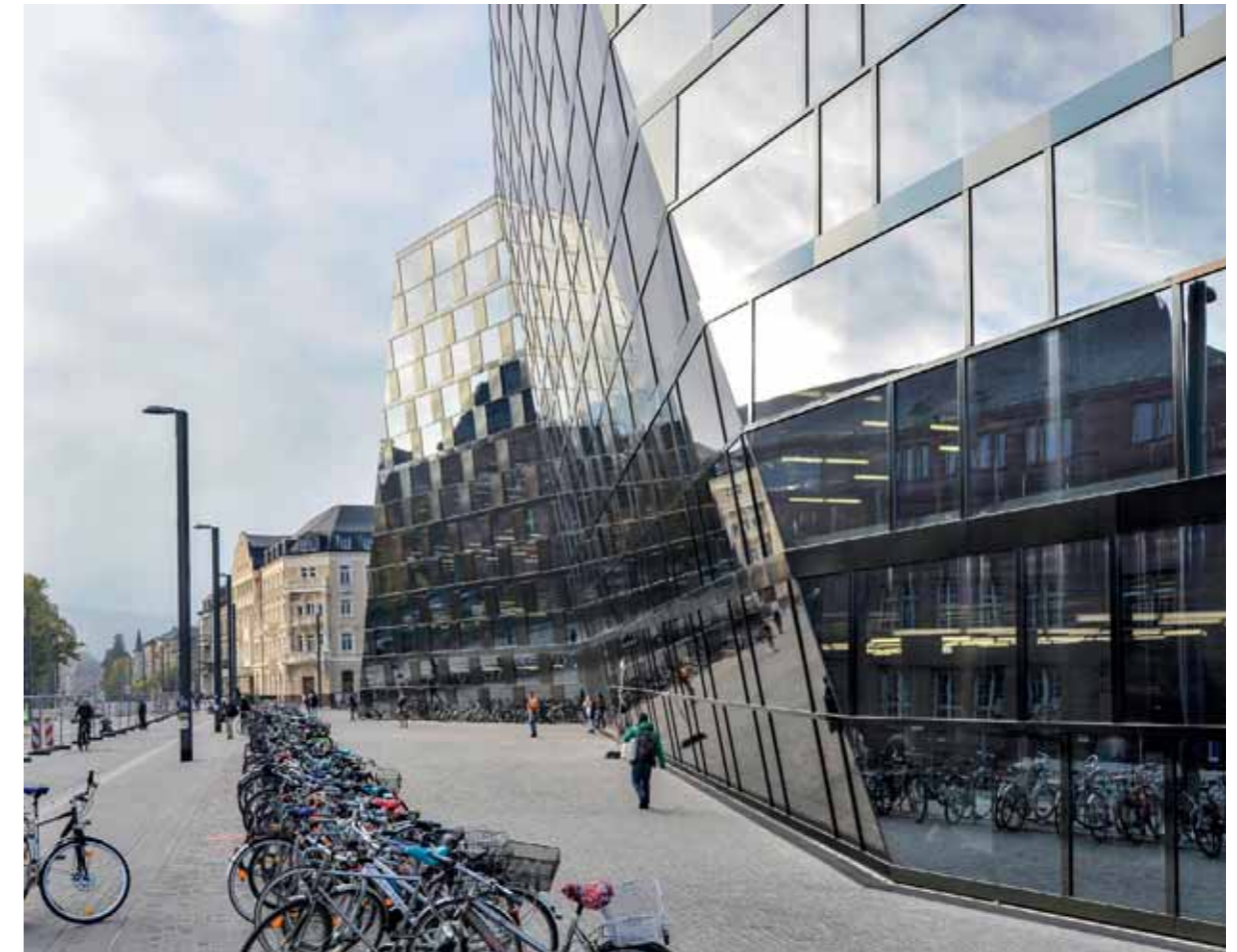
Die besonders große Faltung der Ostfassade zum Campus hebt den Haupteingang hervor Fotos oben und rechts unten: Guido Kirsch
