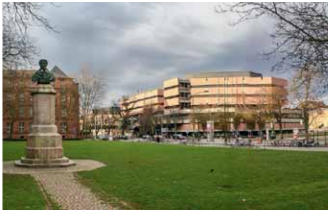
Altbau der Bibliothek aus dem Jahr 1978, vom Platz der Alten Synagoge aus gesehen. Der Eingang befand sich im 1. Obergeschoss und wurde vom Campus über eine Brücke erreicht. Nach dem Abriss blieben nur die Kerne stehen. Die Untergeschosse mit dem Magazin für 3,5 Millionen Bücher blieben unangetastet.
