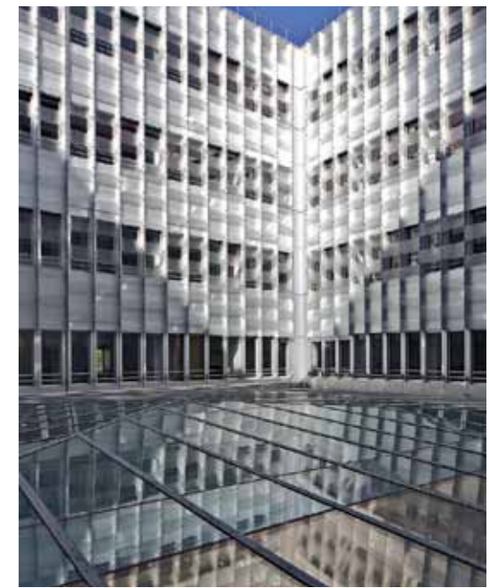
An der Passage entlang der Straßenfassade schließt der Innenhof mit der Patienten Anmeldung an. Über dem Glasdach sind auf vier Ebenen die Patientenzimmer angeordnet.
