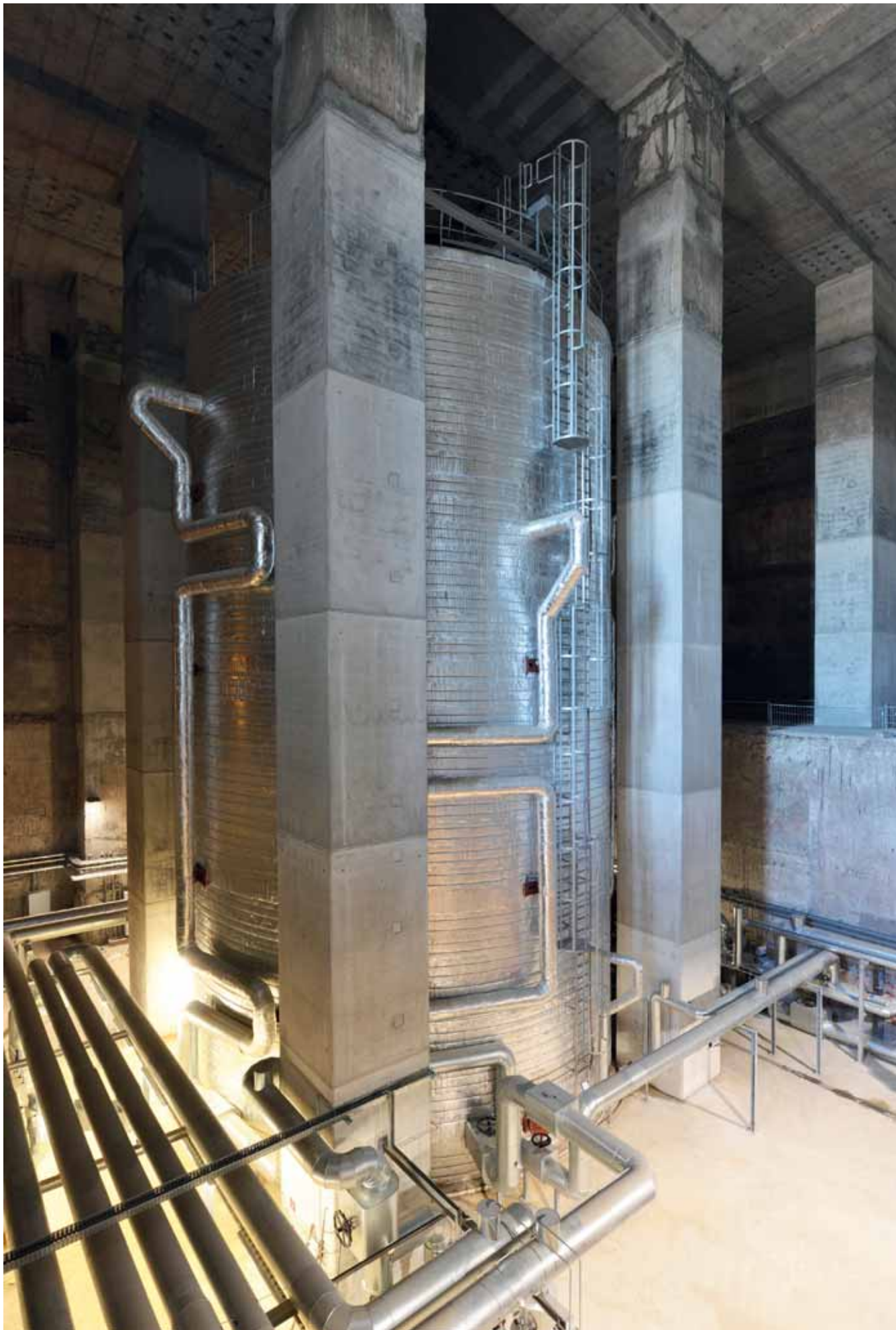
Der ehemalige Flakbunker in Wilhelmsburg wurde im Rahmen der IBA zu einem regenerativen Kraftwerk mit Großwärmespeicher ausgebaut. Rechts: Wie erneuerbare Energien in bestehende Energieversorgungssysteme integriert werden können und welche Kopplungseffekte zwischen Energienetzen möglich sind, erforscht das Projekt TransiEnt.EE (Transientes Verhalten gekoppelter Energienetze mit hohem Anteil Erneuerbarer Energien) Foto: IBA Hamburg GmbH/ Martin Kunze; Diagramm: TU Hamburg-Harburg, Institut für Thermofluidynamik/urbanista/IBA Hamburg GmbH
