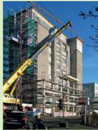
Montage des neuen „Stadtreghals“: Loggien vergrößern die privaten Freiflächen um mehr als das Doppelte
