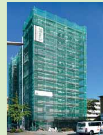
Die Fassade wird bis auf die Rohbaukonstruktion entfernt, sortenreine Trennung der Materialien vor Ort
