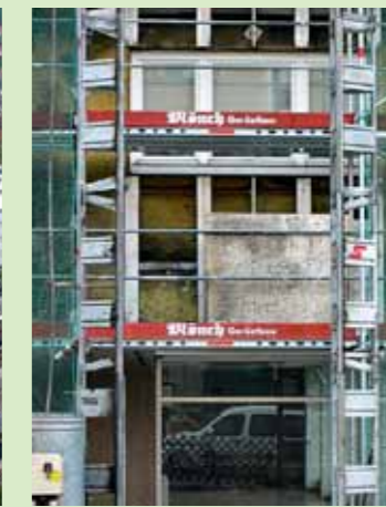
Erster Schritt Fassadenrückbau: Asbestplatten, Dämmung, Unterkonstruktion werden abgenommen
