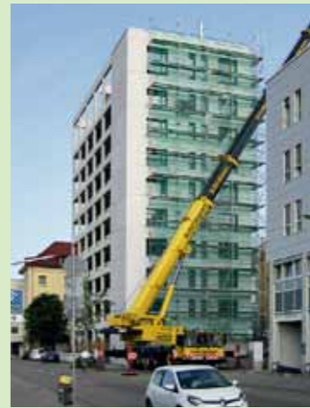
Kurz vor dem Gerüstabbau am Tage der Windradmontage Fotografie: freivogel Architekten
