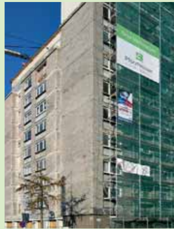
Wohnturm mit Rohbau des neuen Dachgeschosses und „abgesägten“, durchbindenden Balkonplatten
