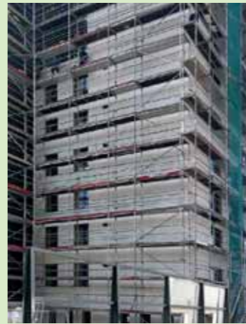
Die Plattengrößen der neuen Fassade, in der Regel 3 auf 5 Meter, reduzierten die Montagezeit
