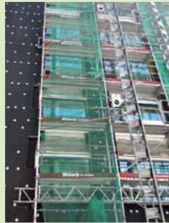
Neue Mineralfaserdämmung, 2 mal 14 cm, auf bestehenden Durisol-Wänden
