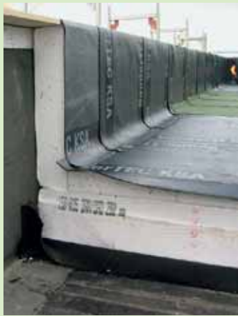
Flachdachaufbau auf dem neuen Penthaus-Geschoss, mit 35 cm Dämmung für Null-Energiestandard
