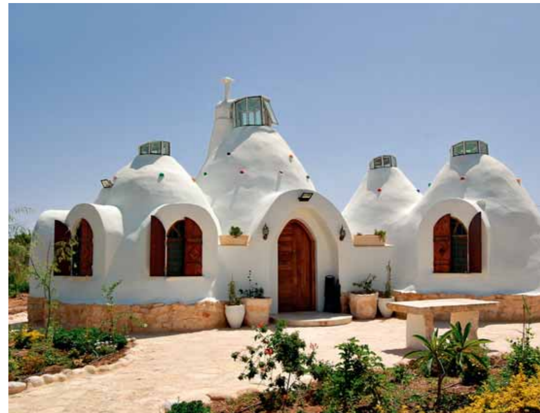
„Mondhaus“ in Jericho. Dicke Lehm-mauern, kleine Fenster und oben gelegene Entlüftung sorgen ganzjährig für ein angenehmes Raumklima
