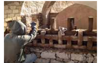
Von einem Frauenzentrum betriebenes Restaurant in Aldyok, nahe Jericho, errichtet in einer Mischtechnik aus Mauerwerk und Lehm-bauelementen. Letztere sorgen in den extrem heißen Sommern für stetige Durchlüftung
