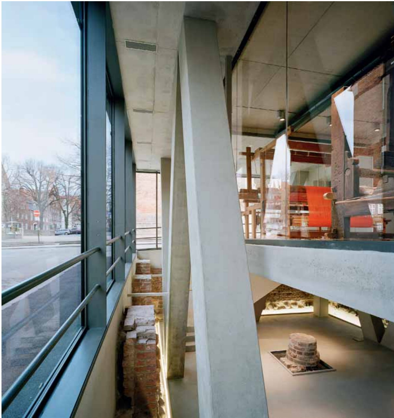
Drei Schichten: Glasfassa- de, acht Jahrhunderte altes Mauerwerk, V-Stützen aus Beton Schnitte im Maßstab 1:500
