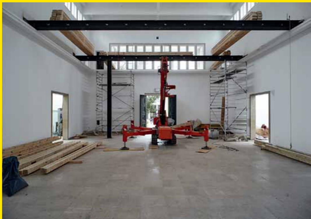
Montage in der zentralen Halle des Pavillons einer zweiten Ebene mit Treppe für eine weitere Ausstellungsfläche
