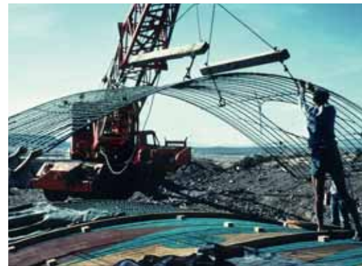
Links: Das heute als Besucherzentrum und Café genutzte Haus entstand 1972–77. Unten: Schalung für den Nordbogen, der aus 12, mit Soleris Abformtechnik hergestellten Teilen besteht. Rechts: Bau des Amphitheaters Anfang der 80er Jahre. Fotos links und ganz rechts: Cosanti Foundation; unten: Ivan Pintar
