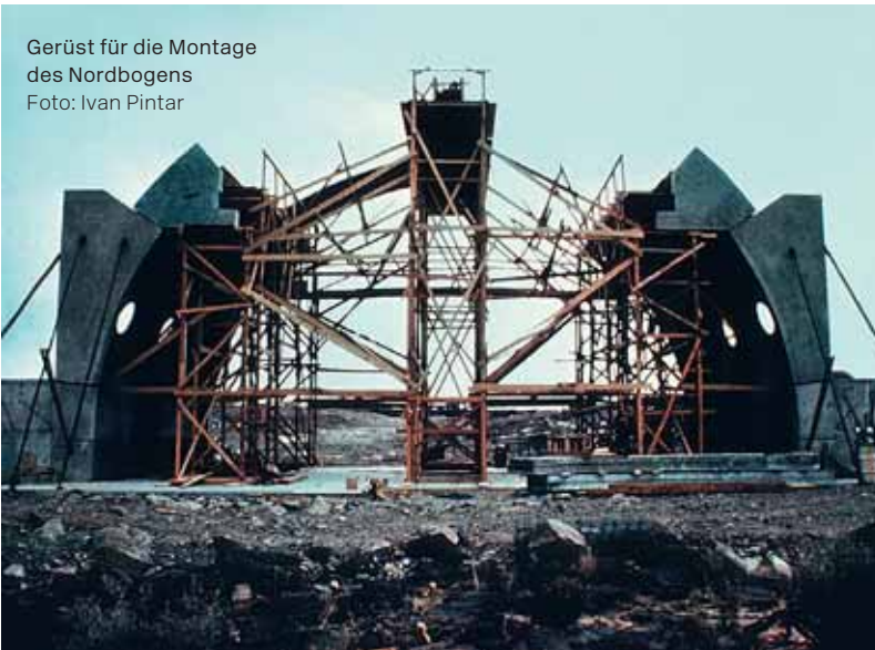
Links: Das heute als Besucherzentrum und Café genutzte Haus entstand 1972–77. Unten: Schalung für den Nordbogen, der aus 12, mit Soleris Abformtechnik hergestellten Teilen besteht. Rechts: Bau des Amphitheaters Anfang der 80er Jahre. Fotos links und ganz rechts: Cosanti Foundation; unten: Ivan Pintar
