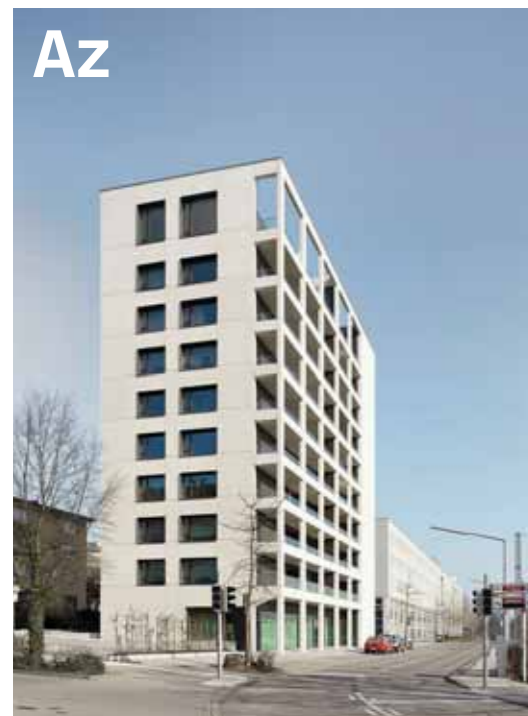
Generalsanierung und Aufstockung Wohnhochhaus in Pforzheim Foto: Dietmar Strauß
