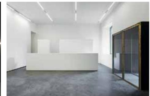
Alle Tür- und Fensteröffnungen – im Vulkansteinmauerwerk ebenso wie im Sichtbeton – erhielten das gleiche Profil aus Messing
