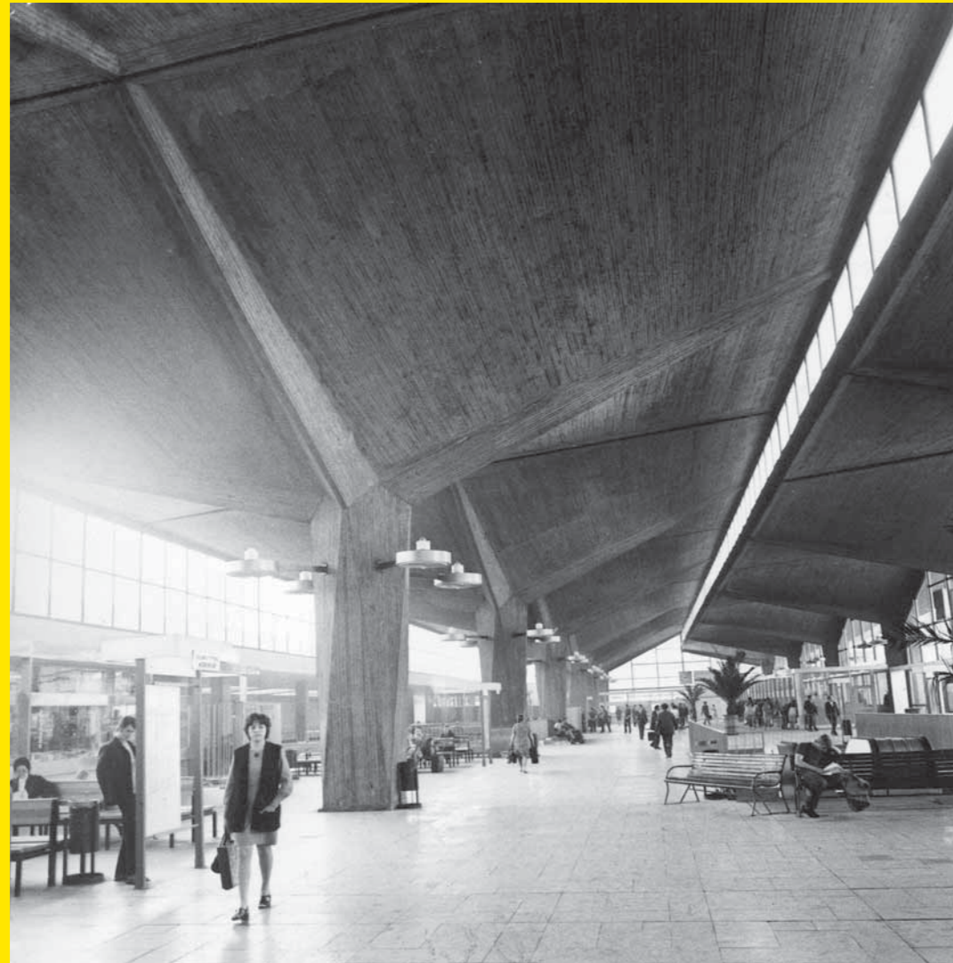
Weitspannende, scharfkantige Betonstützen und großzügige Fensterflächen bestimmten die brutalistische Bahnhofshalle in Kattowitz. Sie musste 2011 einer Shoppingmall weichen.
