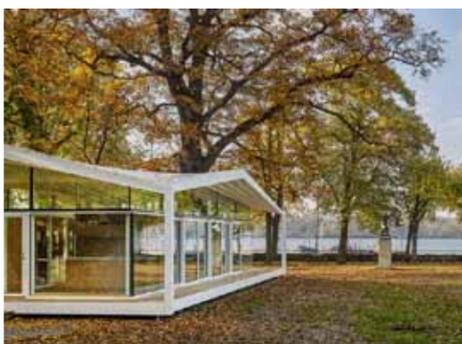
Die Dachform folgt einer regelmäßigen Geometrie, die aus zweidimensional zueinander versetzten und gedrehten Geraden vier hyperbolische Paraboloiden erzeugt
