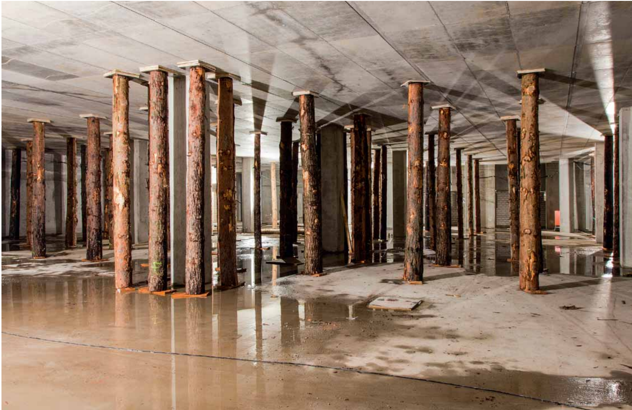
Unter dem Schlosshof wurden 143 Baumstämme als Abstützungen eingefügt, weil oben Baufahrzeuge herumfahren Foto: Schlosswald © Stefanie Bürkle/VG Bild-Kunst 2015
