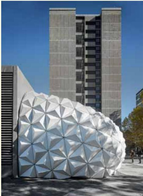
In einem Netz mit verschiedenen großen, dreieckigen Maschen verbaute das ITKE 388 unterschiedliche Formteilen aus Biokunststoff für den Mock-Up einer Fassade
