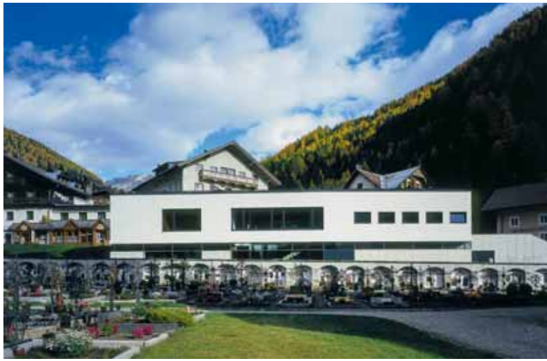
Das „Glocknerhaus“ (1997–2000) auf einem schmalen Grundstück zwischen Friedhofsmauer und Straße: Servicecenter für Gemeindegänger und Gäste, mit Tourismusbüro, Informationsstelle des Nationalparks Hohe Tauern, Bankfiliale und einer Ausstellung zum Großglockner, dem höchsten Berg Österreichs
