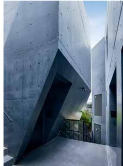
Architekt Akihisa Hirata wählte für die Durchfärbung seines Sichtbetons einen fast schwarzen Farbton. Er teilte den Bau in vier voneinander abgesetzte Blöcke mit insgesamt 12 Wohnungen auf.
