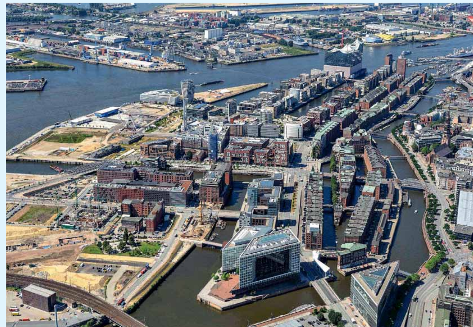
Interessante Paradoxien: Stand der HafenCity-Bebauung, Sommer 2014, zwischen Spiegel-Haus und Elbphilharmonie Foto: HafenCity Hamburg GmbH/Burkhard Kuhn
