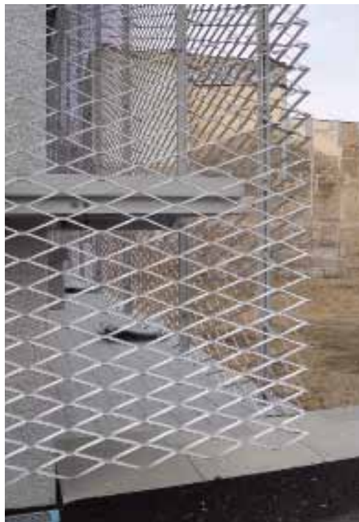
Schnitt mit vorgehängter Fassade, Rampe und Vordach; Detail des Streckgitters (Maschenweite 30x10 cm). In das Sockelgeschoss auf der Spree-seite ist das Architekturbüro gezogen Detailschnitt im Maßstab 1:150, Schnitt 1:500; Foto oben: SR
