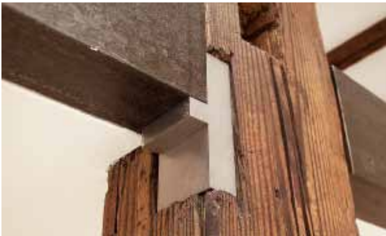
Oben: Durch Oberlicht und begehbare Glas in der Decke fällt Licht in das Werkstattbüro im Erdgeschoss. Unten: Das Auflager für die Empore bildet ein L-Profil
