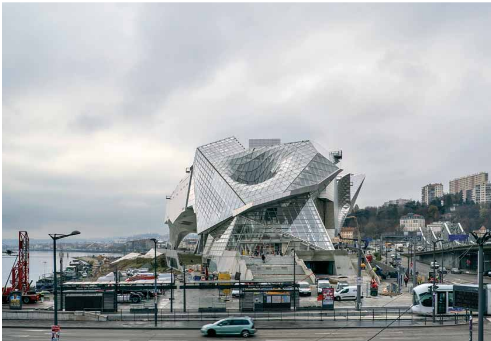
Eingangshalle mit Loch im Dach, das in den „Trichter“ mündet. Hinter dem Museum die Spitze der Halbinsel Foto: Duccio Malagamba
