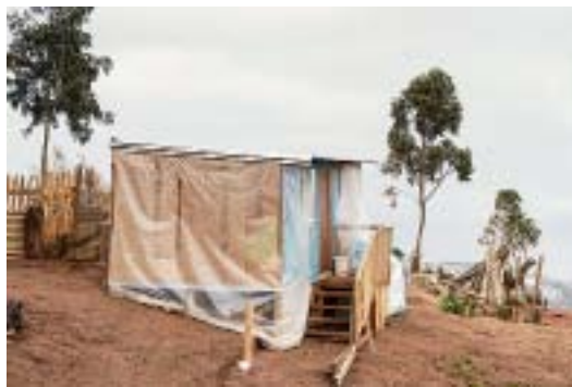
Die schmalen Hügelkämme mit den Campamentos gelten als Gefahrenzonen für Erdbeben. Die mit simpelsten Mitteln zusammengefügte Bauten finden auf Holzstützen Halt.
