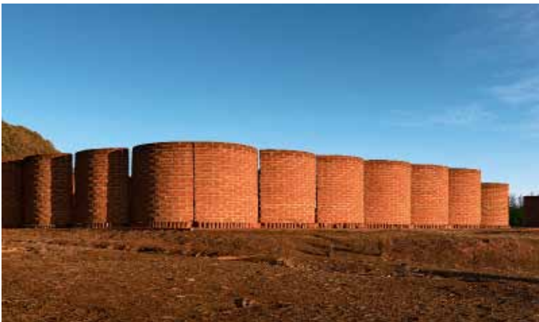
Die hölzerne Skulptur auf einer Anhöhe im Gelände wurde von Architekturstudenten im Grundstudium errichtet. Die gewölbten Ziegelmauern fassen einen offenen „Theaterplatz“.
