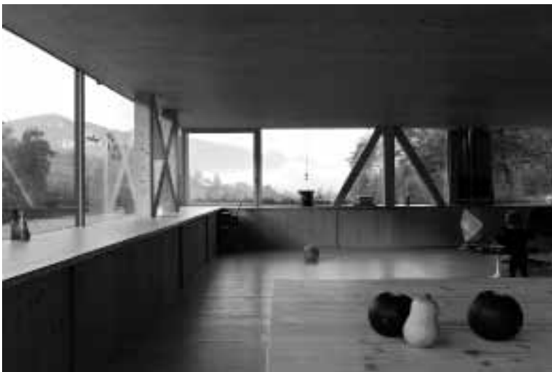
Von außen bodentiefe Fenster, innen mit Brüstung Fotos: Pascal Flammer; 2. Foto v.r.: Ioana Marinescu
