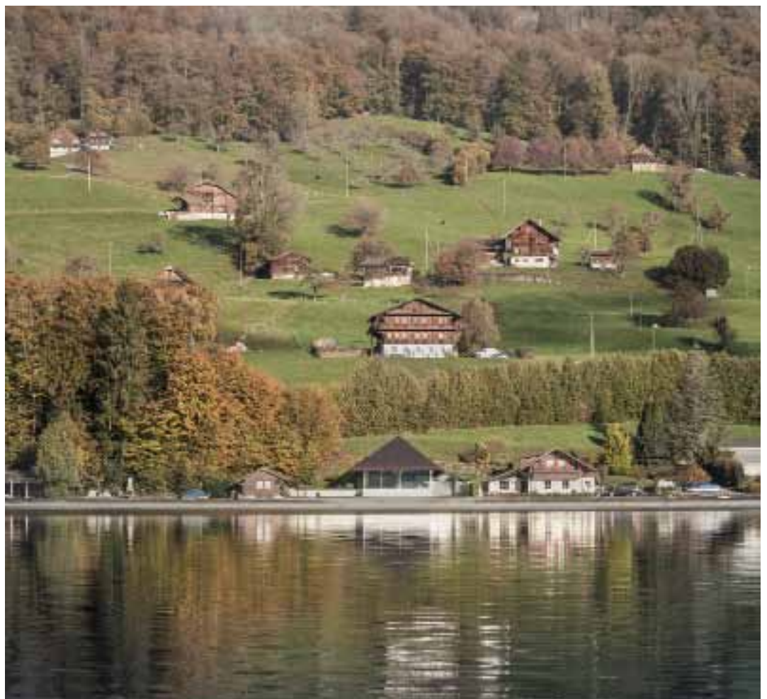
Die Grate des Zeltdaches zeichnen die Giebel dreiecke der benachbarten Häuser nach
