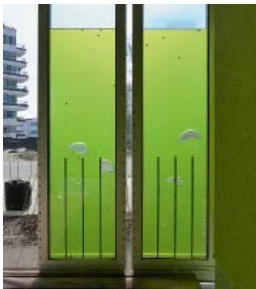
In der SolarLeaf-Fassade werden Mikroalgen in flachpaneelförmigen Fotobioreaktoren gezüchtet Foto: Colt, SSC, Arup
