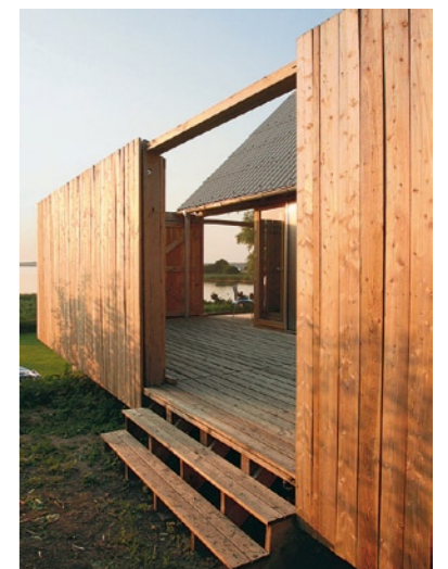
Schiebetore in den Seitenwänden dienen als Eingang, ein großes Tor in der Stirnwand dem Ausblick.
