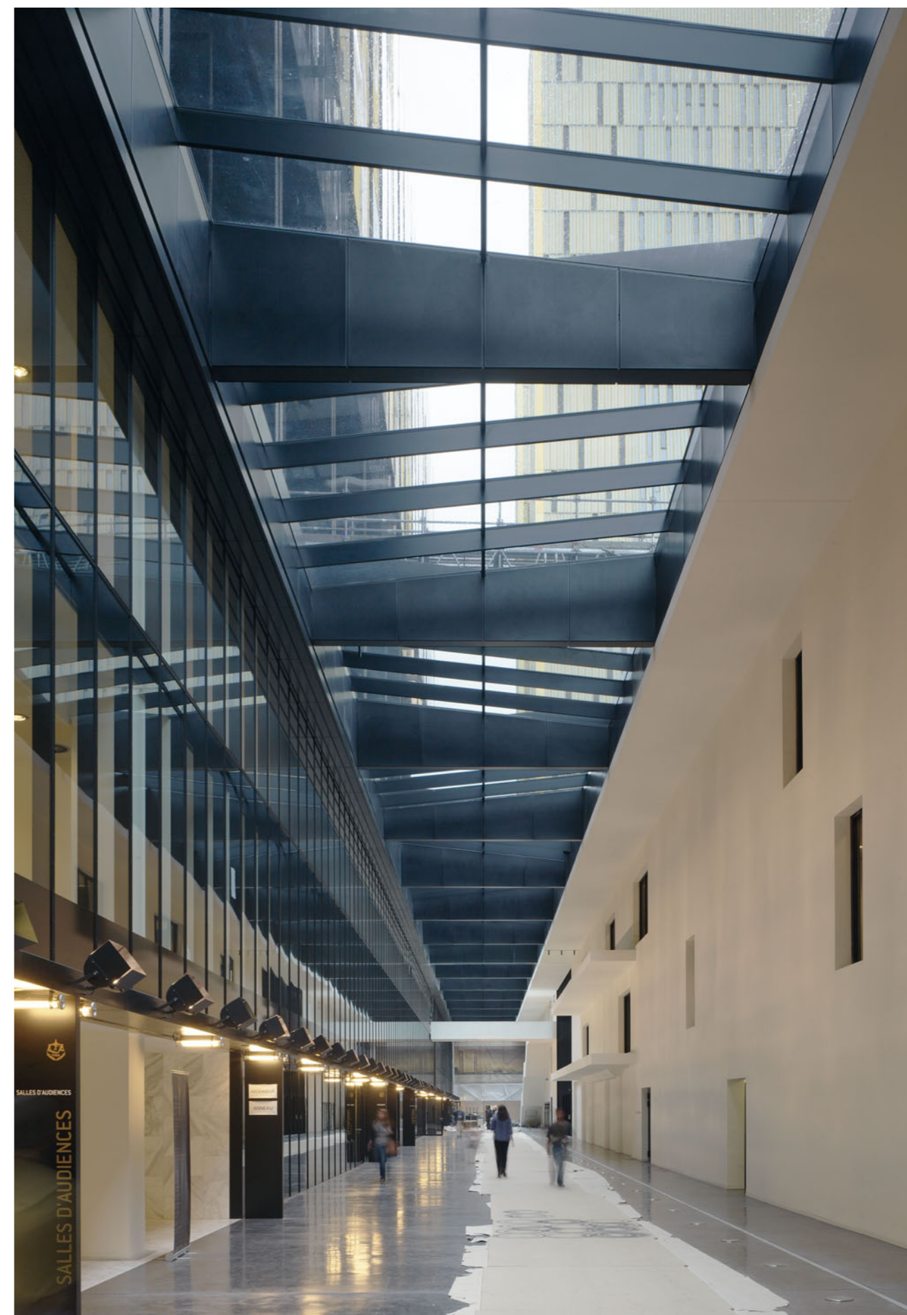
Hinter der Wand rechts verbergen sich die im Sockelbereich liegenden Erweiterungsbauten der 80er Jahre. Durchbrüche stellen neue Verbindungen her. Noch bis 29. September ist im Centre Pompidou Paris die Ausstellung „Dominique Perrault Architecture“ mit Modellen der Bauten in Seoul und Luxemburg zu sehen.
