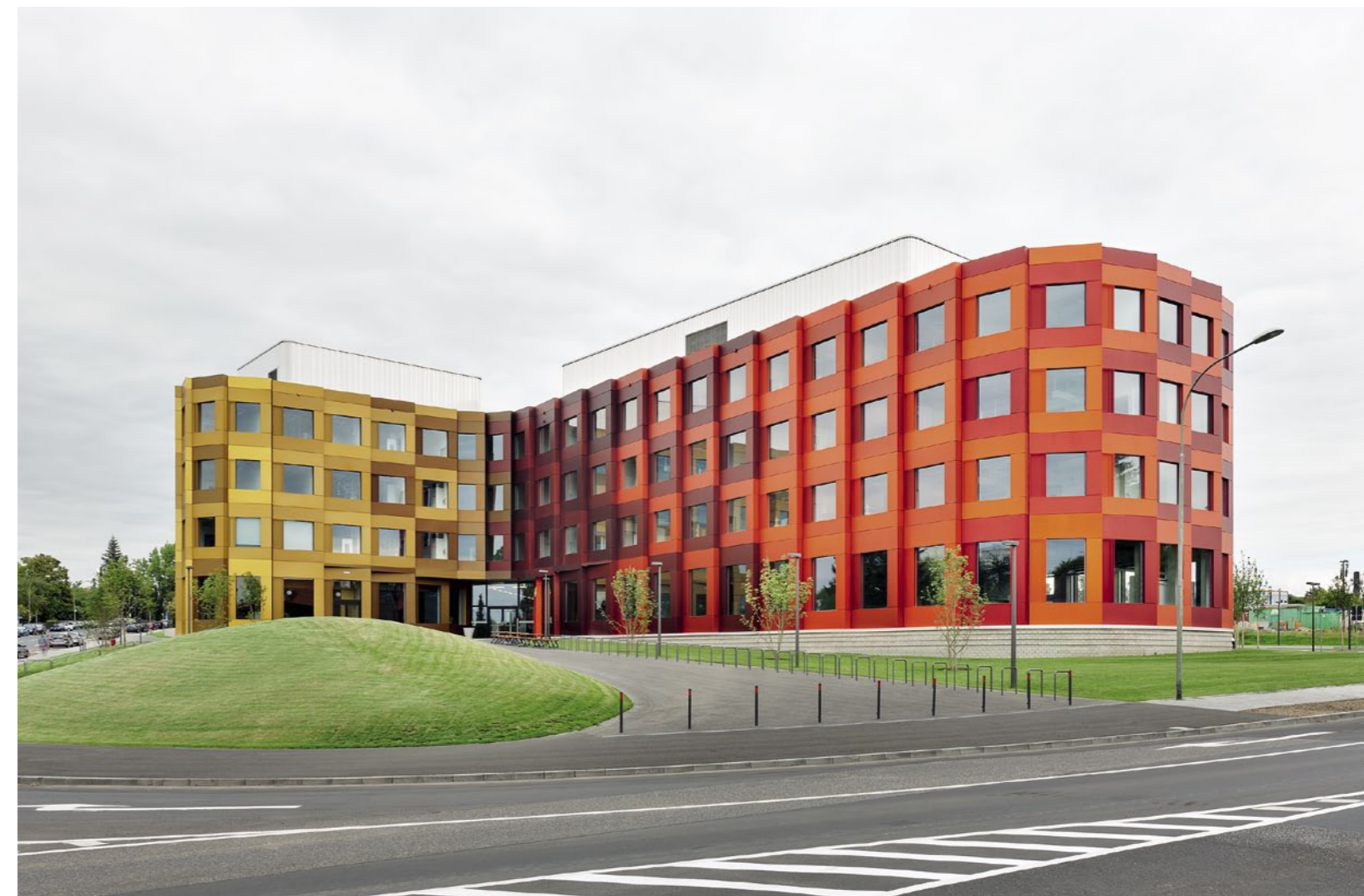
Haupteingang und Cafeteria orientieren sich zur städtebaulich prominentesten Ecke des Areals, zur Kreuzung von Aulweg und Schubertstraße.
