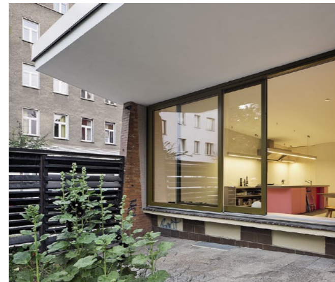
Die alten Schaufenster wurden durch neue Schiebefenster ersetzt
