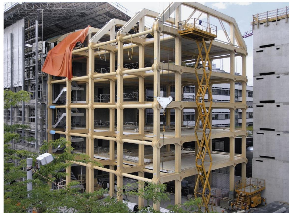
Bei den Knoten fand auch härteres Buchenholz Verwendung. Rahmen für Rahmen wurden in ganzer Höhe aneinandergelagert. Links im Bild das Schutzdach für die Aufstockung des Nebengebäudes
