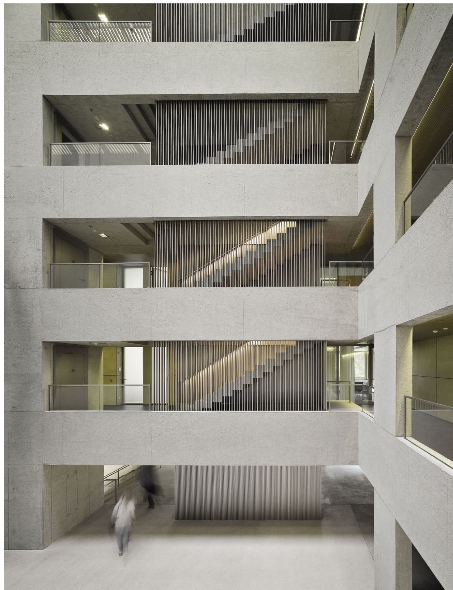
Das Interieur bestimmen heller sandgestrahlter Sichtbeton und im gleichen Ton geschliffener Estrich
