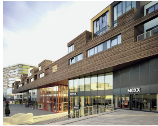
De Citadel: Zwei verglaste Ladungsetage (37.000 m 2 ) bilden die Basis für die Wohnungen (8000 m 2 ), die in Reihenhausanmutung ein be- grüntes Dach umstehen; der kleine Wohnturm hat sechs Apartments. Fotos: Christian Richters
