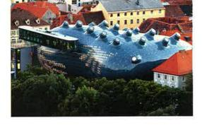
Für die BIX-Fassade wurden handelsübliche ringförmige 40W-Leuchtstoffröhren mit einem Durchmesser von 40 cm verwendet. Jede kann einzeln von einem zentralen Rechner angesteuert und stufenlos reguliert werden. Über den 45 m breiten und 20 m hohen Bildschirm können schematische Animationen, grob gerasterte Graphiken, Lettern, Filmsequenzen laufen, wofür Künstler beauftragt werden sollen. Bildwechsel von etwa 20 Bildern/ Sekunde sind möglich.
