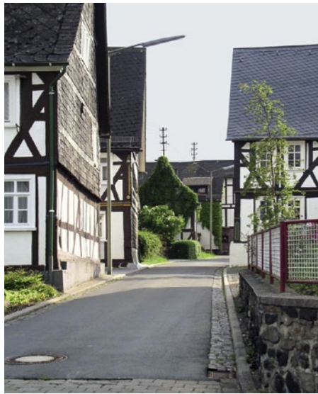
Fachwerk in Burbach-Holzhausen
