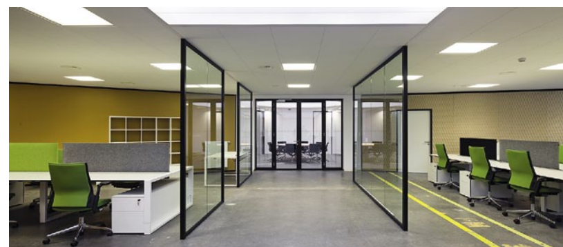
Gläserne Trennelemente im Verwaltungsbereich
