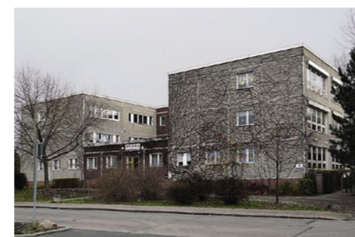
Kindertagesstätte „Burg“ vor Sanierung und Umbau ...
