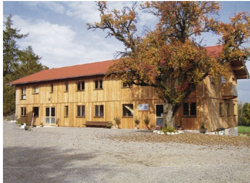
Um die Abwanderung der jüngeren Generation zu verhindern, genehmigt die Gemeinde neue Gewerbebauten in Hofnähe. Links: eine Werkstatt im Ortsteil Sonderdilling
