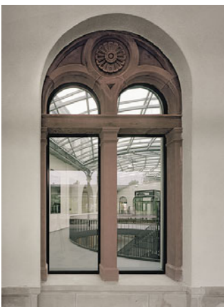
Blick vom Bahnsteig in das Obergeschoss des Verbindungsbauwerks. Wie der hintere Trakt mit dem ovalen Kaisersaal ist auch dieses Bauteil ein Rest des abgebrannten Vorgängerbaus aus dem Jahr 1872.
