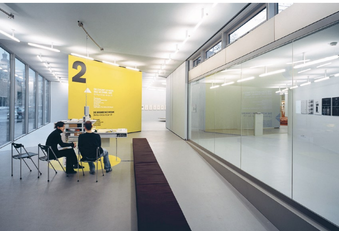
Eine raumhohe Verglasung trennt das Foyer vom Projektraum, der wie der zuschaltbare Sammlungsraum im Zentrum des Gebäudes vollklimatisiert ist. Der größte Teil des Hauses wird über Fensterschlitze und Oberlichter natürlich be- und entlüftet.
