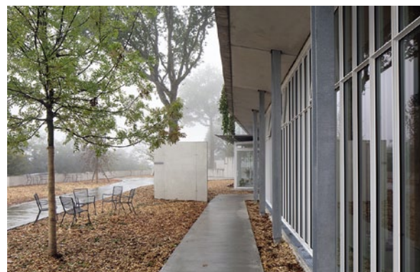
Die Neubauten mit breiter Vorzone zum Wald und der Gemeinschaftsraum mit Patio. Unten: Baustellenbesuch mit Projektleiter Paul Vincent.
