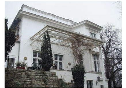
Die alte Loggia
