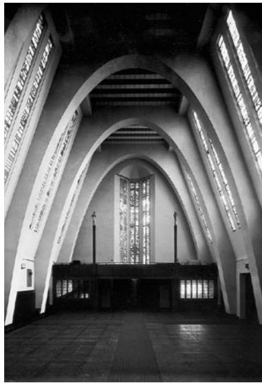
Der Blick zum Chor der großen Feierhalle 1933 und heute. Die historische Schnittzeichnung verdeutlicht die Technik.
